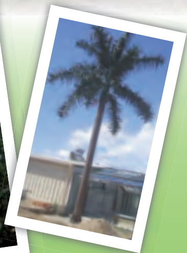
Site Bouygues Telecom Cagnes sur Mer (06) • 12 m
