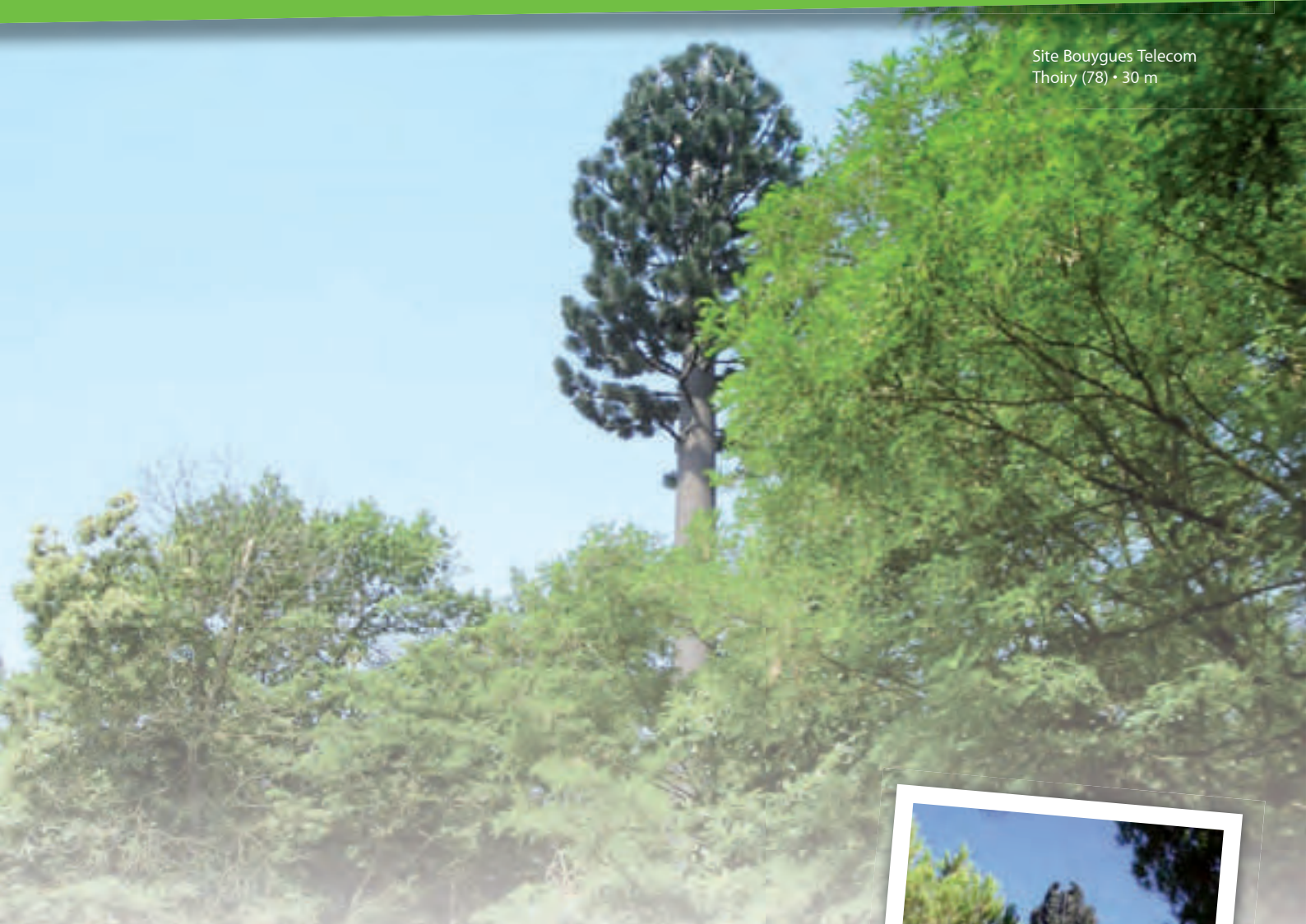
Site Bouygues Telecom La Trinité sur Mer (56) • 25 m
