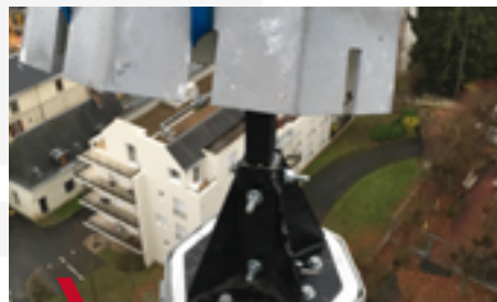
2 > Installation de la nouvelle croix composite sur le manchon existant
