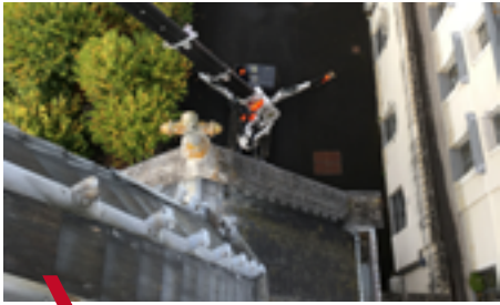
1 > Accès au sommet par nacelle
