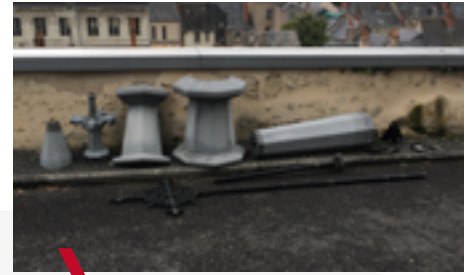
3 > Conservation d'éléments » réutilisation » création des moules
