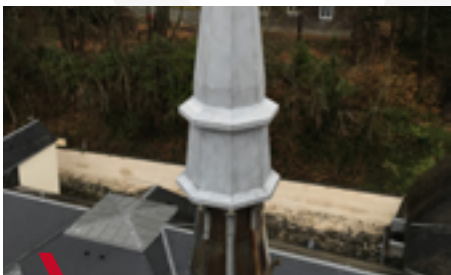
1 > Fixation de la base et du tronc sur le pignon du clocher
