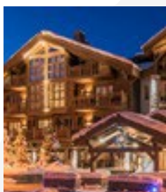
»» COURCHEVEL 1850 Wood-style chimney
